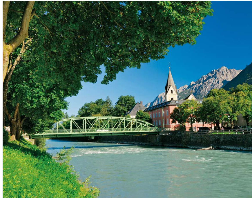
Spitalsbrücke mit Spitalskirche.
